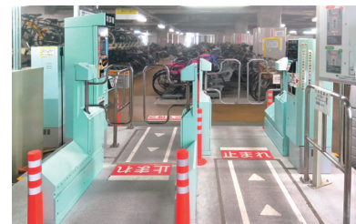
ゲート式駐輪場管理システム (自転車駐車場整備センター様 ひばりヶ丘駅南口自転車駐車場)
