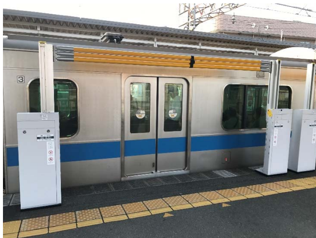
昇降バー式ホーム柵 9月24日（日）より稼動予定
